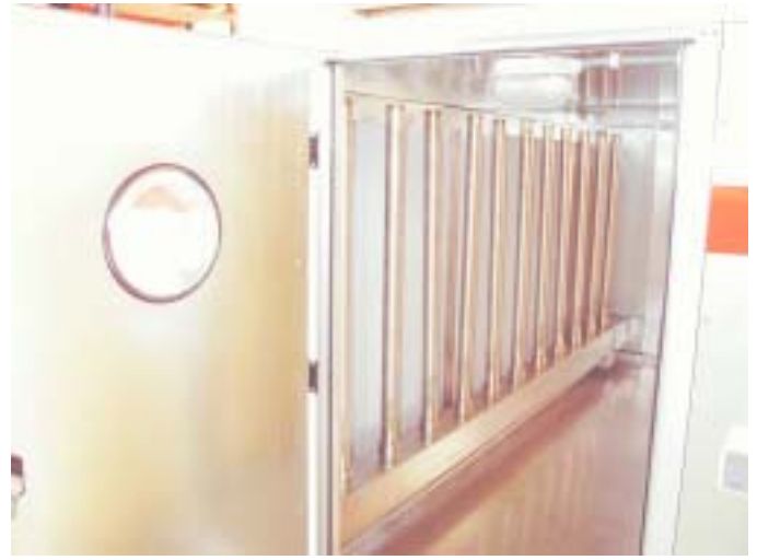
Dampfbefeuchtermodul
